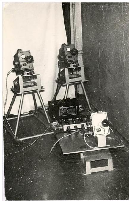
Рис. 2. Первая версия комплекса фотоаппаратуры ПД28, установленная на борту самолета ИЛ-18д в 1973 году
