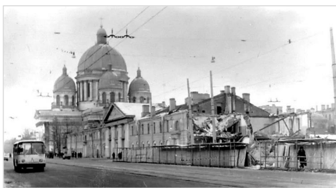
Снос части Манежа Измайловского полка. 1970-е гг. [5]
