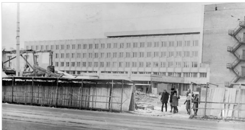
Строительство первой очереди учебно-лабораторного корпуса Военмеха. 1970-е г. Архив Музея БГТУ «ВОЕНМЕХ»
